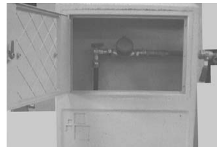
EXEMPLE D'ARMARI AMB SÒCOL DE FORMIGÓ
